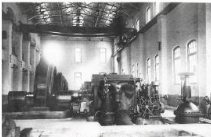
完成直後の第一発電所
