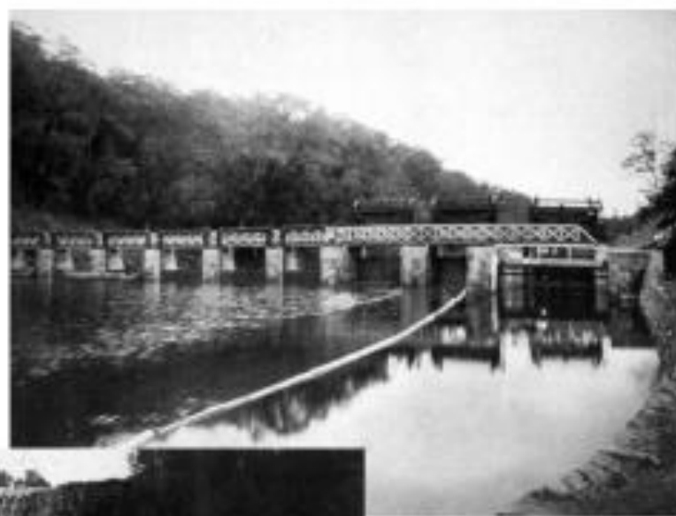
第一発電所に送水するための堰堤
